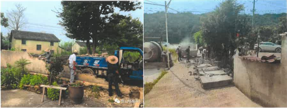
◆ 拆除超占面积围墙，还路于民
